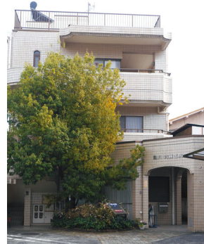
細川・内藤医院外観
