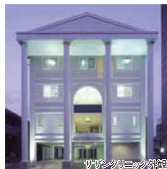
サザンクリニック外観
