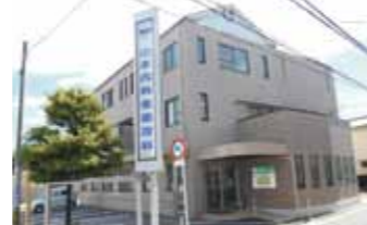
山本内科循環器科外観
